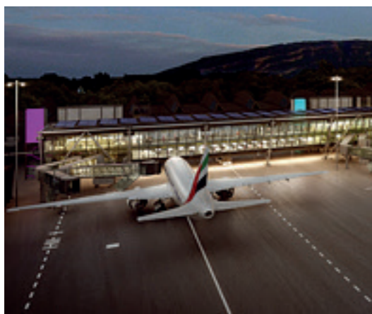
Photo Aéroport International de Genève L'Aile-Est se présentera comme un couloir vitré de 2 étages et de 520m de long.
